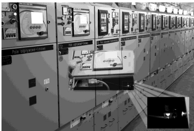
Rys. 5 Test zabezpieczenia łukoochronnego. Figure 5. Arc fault protection testing.
